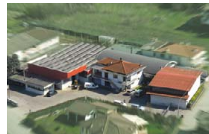
Training Center La Nordica-Extraflame Montecchio Precalcino
