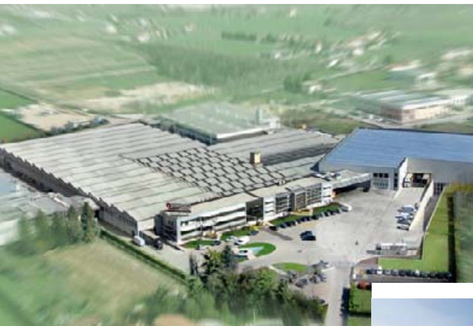
Stabilimento La Nordica Montecchio Precalcino
