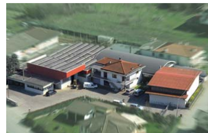
Training Center La Nordica-Extraflame Montecchio Precalcino
