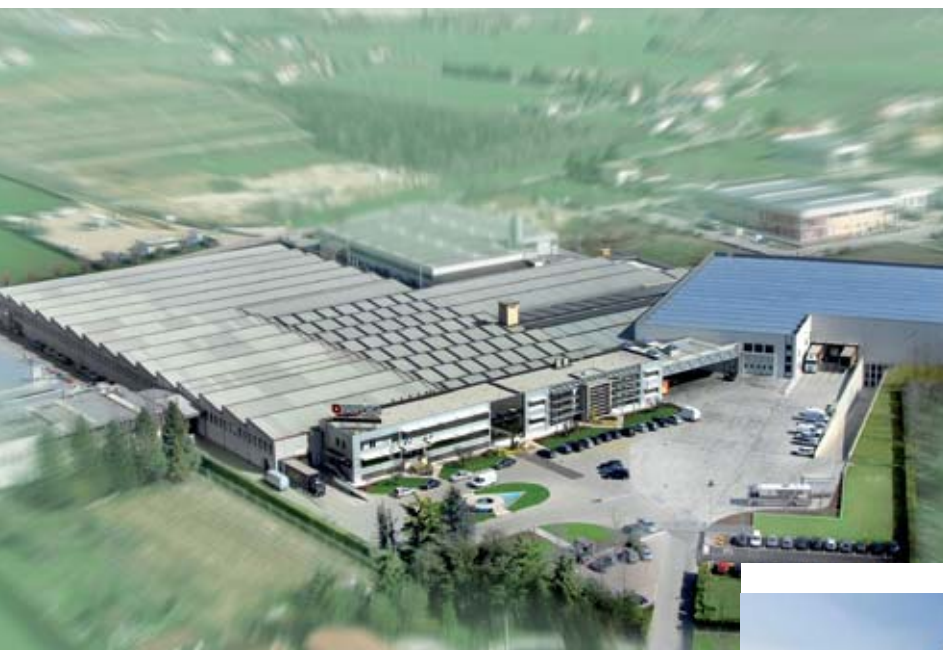
Stabilimento La Nordica Montecchio Precalcino
